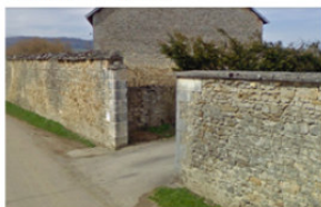
En pierre maçonnée
