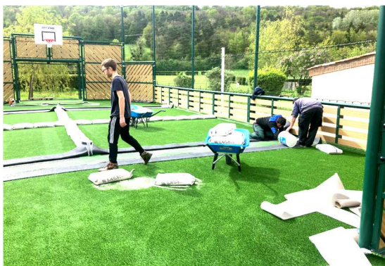
L'installation réalisée par l'entreprise SAE qui a embauché un jeune du village pendant les vacances scolaires
