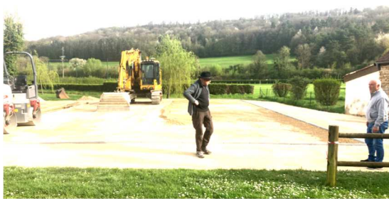
Terrassement réalisé par l'entreprise TerraVosges située à Liffol-le-Petit
